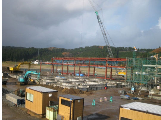
②つなぎ場棟
